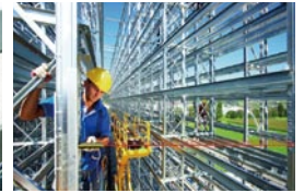
危険な現場での水平距離測定
